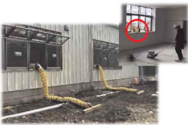
送風機を稼働し、換気を推進
