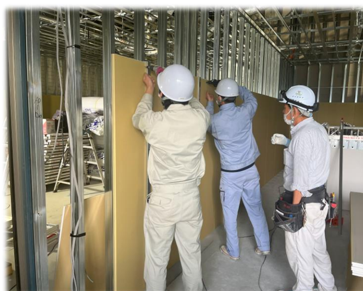
内装 工事体験
