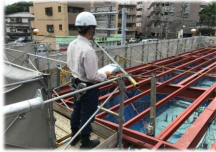
作業環境の点検
