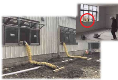
送風機を稼働し、換気を推進
