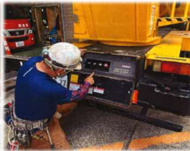
工事用機械点検実施
