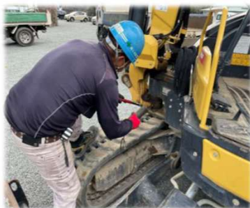
工事用機械点検・整備の実施
