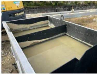
① さく井 掘削泥水 ノッチタンクへ1次排水
